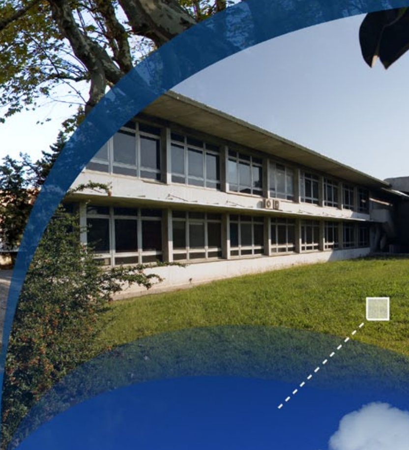
Le bâtiment de 1970 : le projet de réhabilitation
